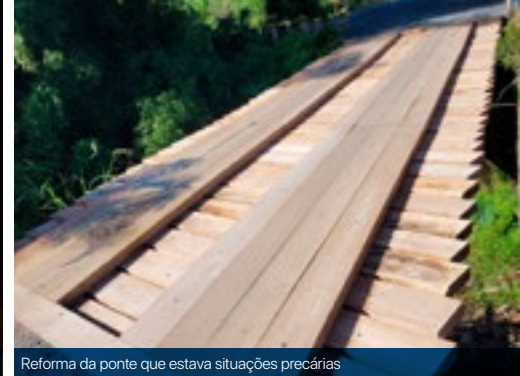
Reforma da ponte que estava situações precárias
