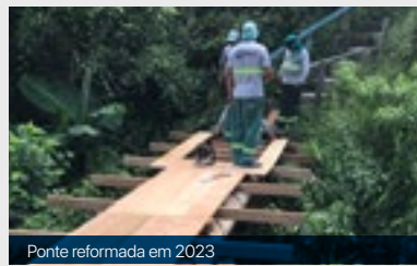
Ponte reformada em 2023
