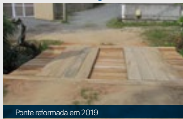
Ponte reformada em 2019
