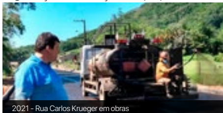
2021 - Rua Carlos Krueger em obras
