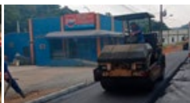
Rua Paulo Zingel Filho em obras
